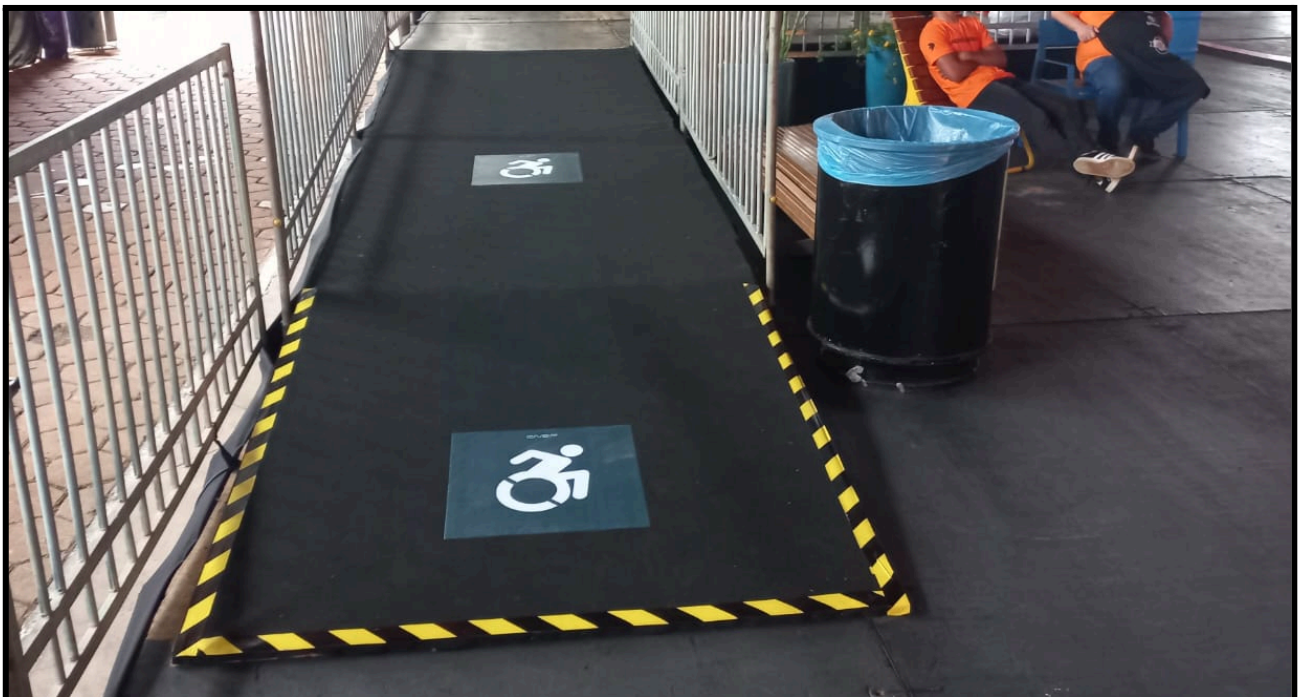
Foto: rampa sinalizada para o elevador PCD.
