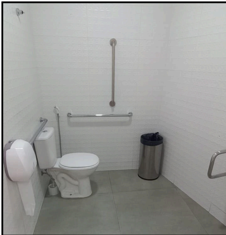
Foto: banheiro PCD interno.
